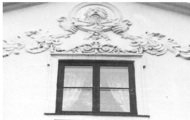
Exempel på vacker fasadutsmyckning.
