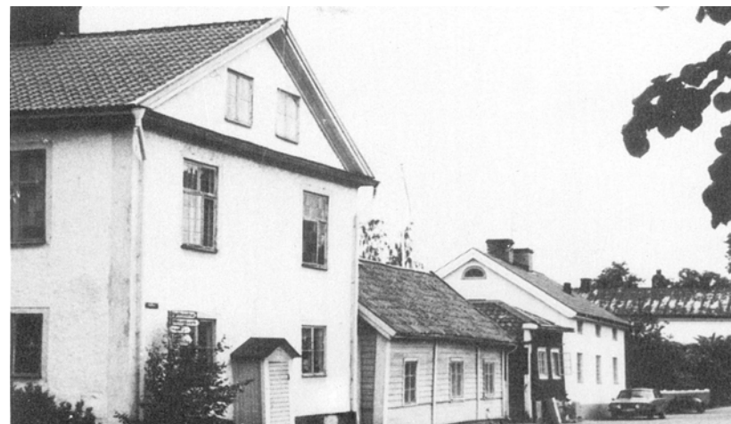
Bebyggelsen inom område B är till största delen från 1800-tal och tidigt 1900-tal, men har också inslag av småskalig äldre bebyggelse.
