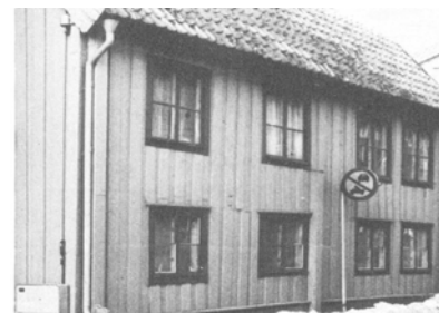
Stående lockpanel har gamla anor. Utförandet ger god beständighet mot röta genom god vattenavrinning och luftning.
