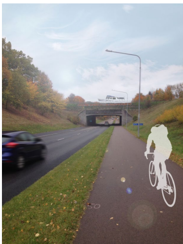
E22 kommer att passera Göta kanal i en akvedukt
