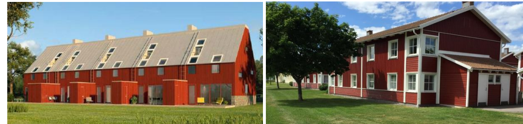
Bild 10: Till vänster i bild är ett modernt radhus där stadsmässig och lantlig karaktär möts. Källa: Aneby hus, arkitekt Sandell Sandberg. Till höger visas ett befintligt flerbostadshus norr om Albogaleden utmed gatan.
