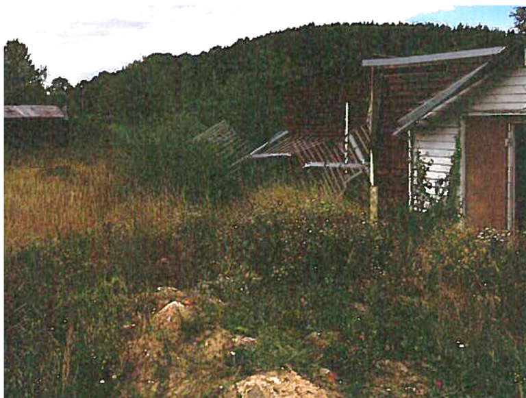
Bild 16. Bilden visar det före detta bostadshuset "Lilla Edet" innan det revs 1999. Källa: Söderköpings kommun.
