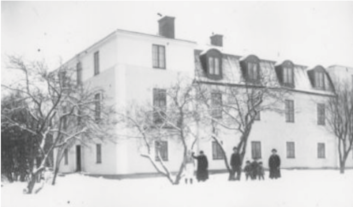
Fasad mot söder. Ny bruten takform på mittpartiet. Vindsvåningen inreddes och försågs med takkupor (S:t Ragnbilds Gilles bildarkiv).
