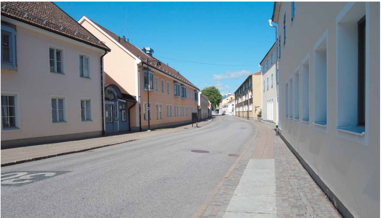
Längs Skönbergagatan nordväst om fastigheten Lagberg 1 har bebyggelsen en stadsmässig karaktär (Fredriksson arkitektkontor 2020).
