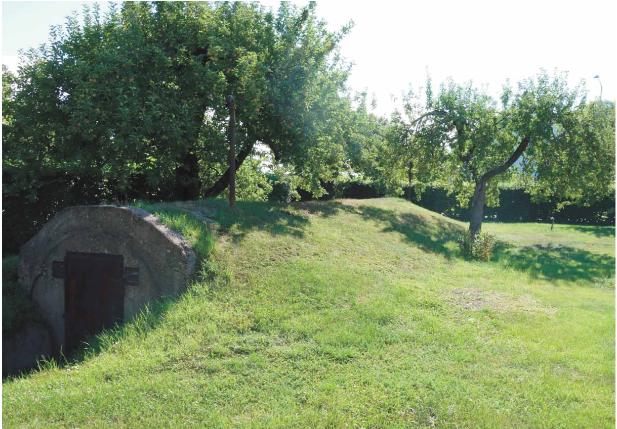
Rörskyddsrum från sydväst (Fredriksson arkitektkontor 2020).
