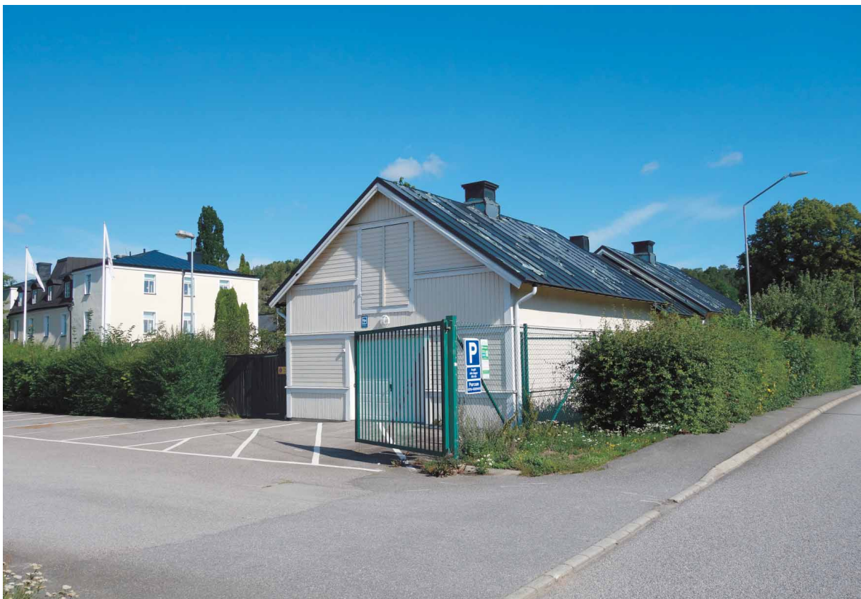
Poolområdets uthusliknande bebyggelse längs Lagbergsgatan (Fredriksson arkitektkontor 2020).
