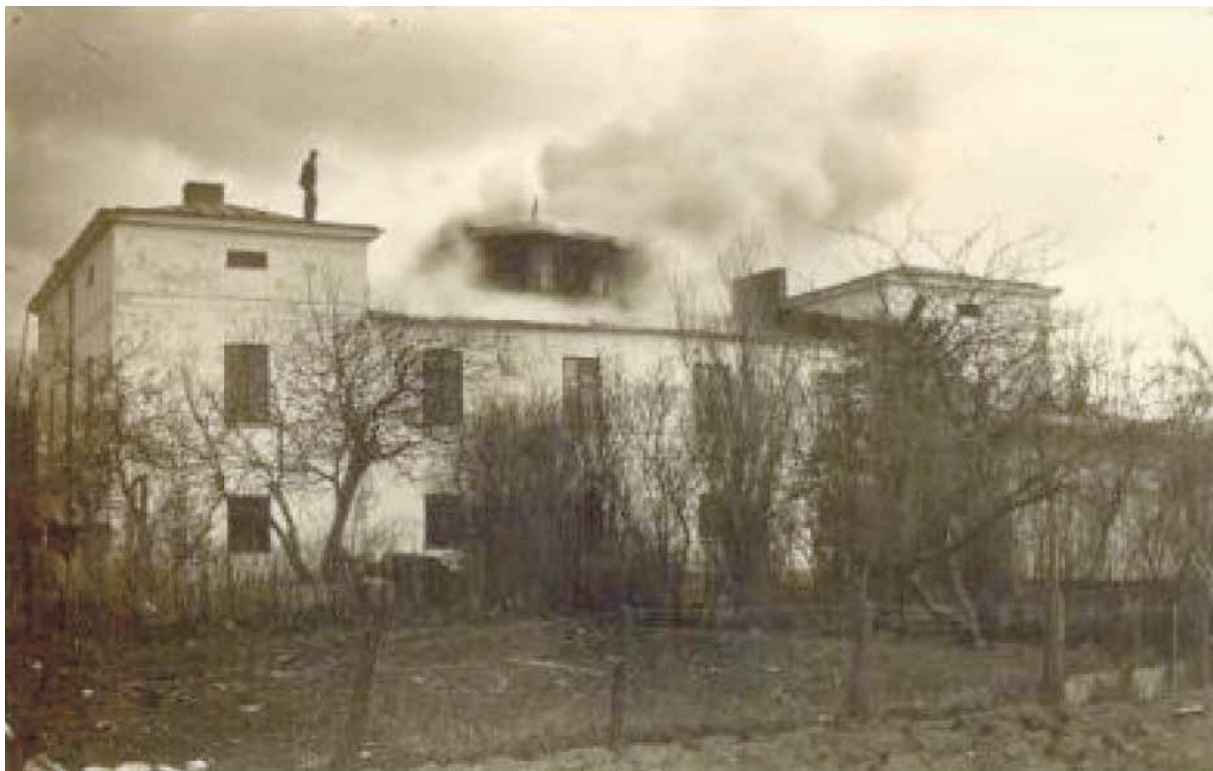
1923 brann Lagbergiska villan, vilket fick till följd att taket och i viss mån även fasaderna omgestaltades (S:t Ragnbilds Gilles bildarkiv).
