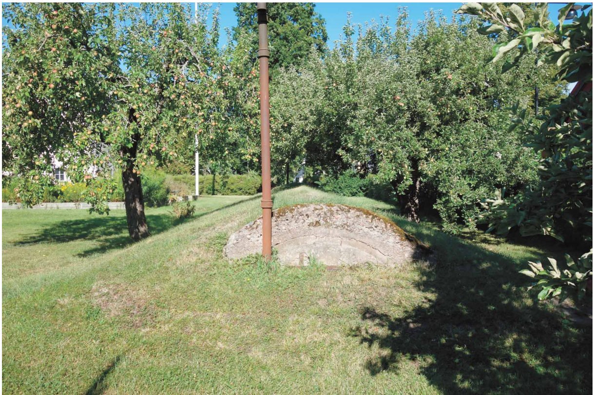
Rörskyddsrum från öster (Fredriksson arkitektkontor 2020).
