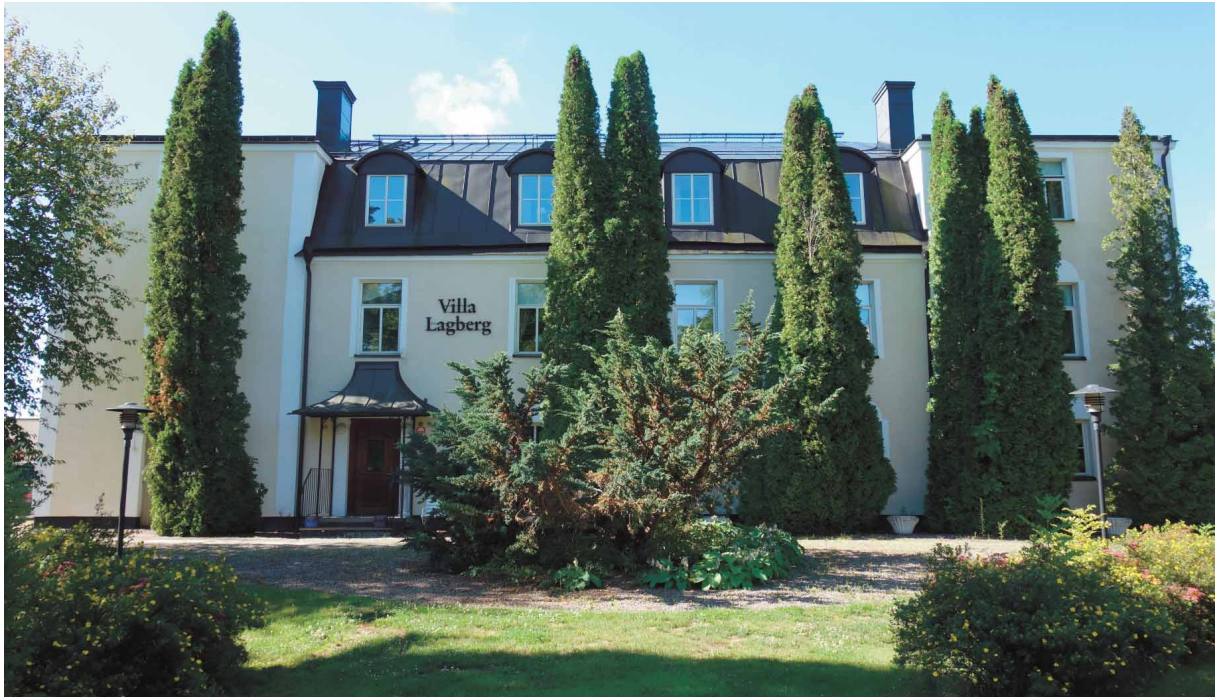
Huvudfasad mot norr. Sidorisaliterna är inte längre lika framträdande genom att taket på mittpartiet höjts och byggt om (Fredriksson arkitektkontor 2020).
