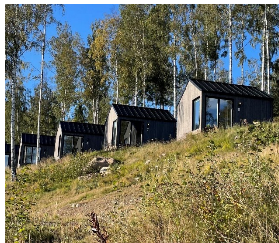
Figur 35. Foto på små uthyrningsbus med fönster placerade så att varje bus har utsikt utan att se in i grannbuset. Foto Sweco.
