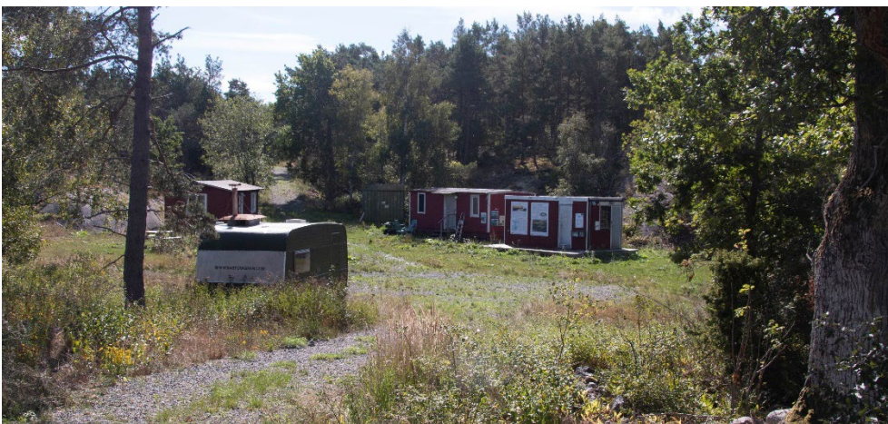
Figur 3-2. De befintliga byggnaderna på den centrala delen av Bergön.
