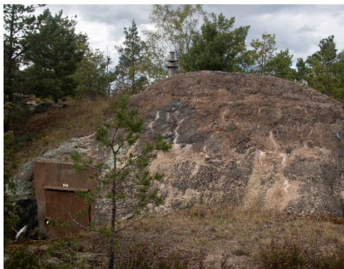
Figur 3-4. Foto på en ingång till av de militära anläggningarna.
