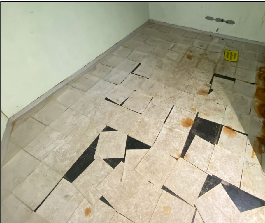
Figur 9. Plattor och lim innehållande asbest
