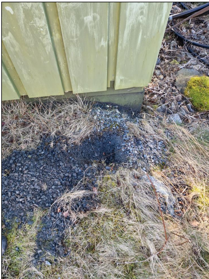
Figur 8. Provgrop vid transformator
