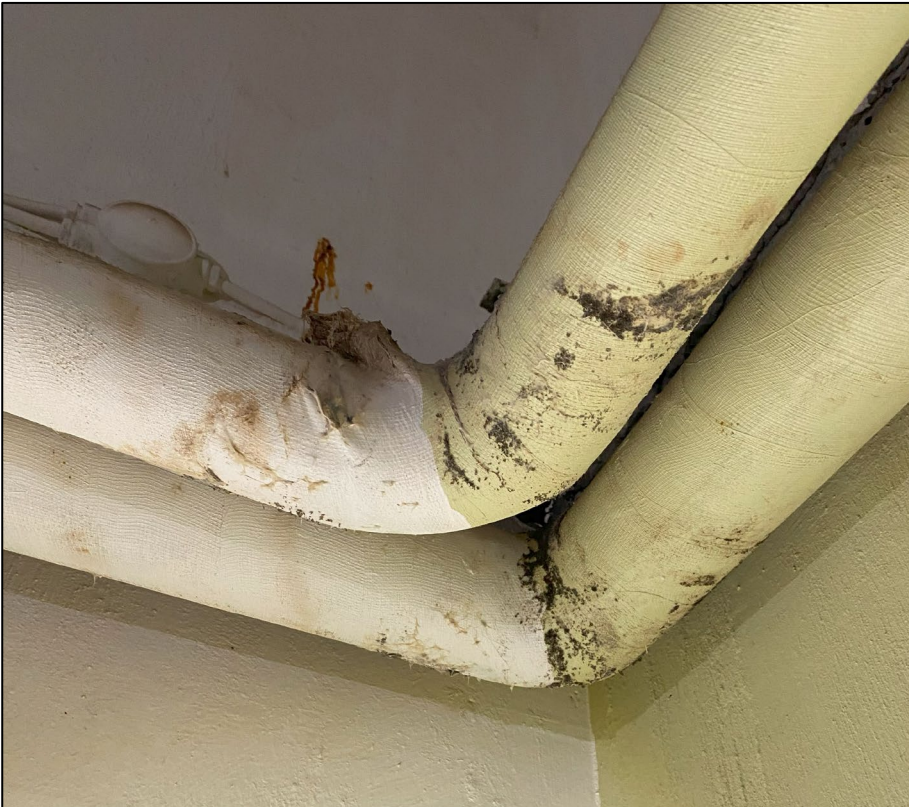
Figur 8. Rörböjar innehållande asbest
