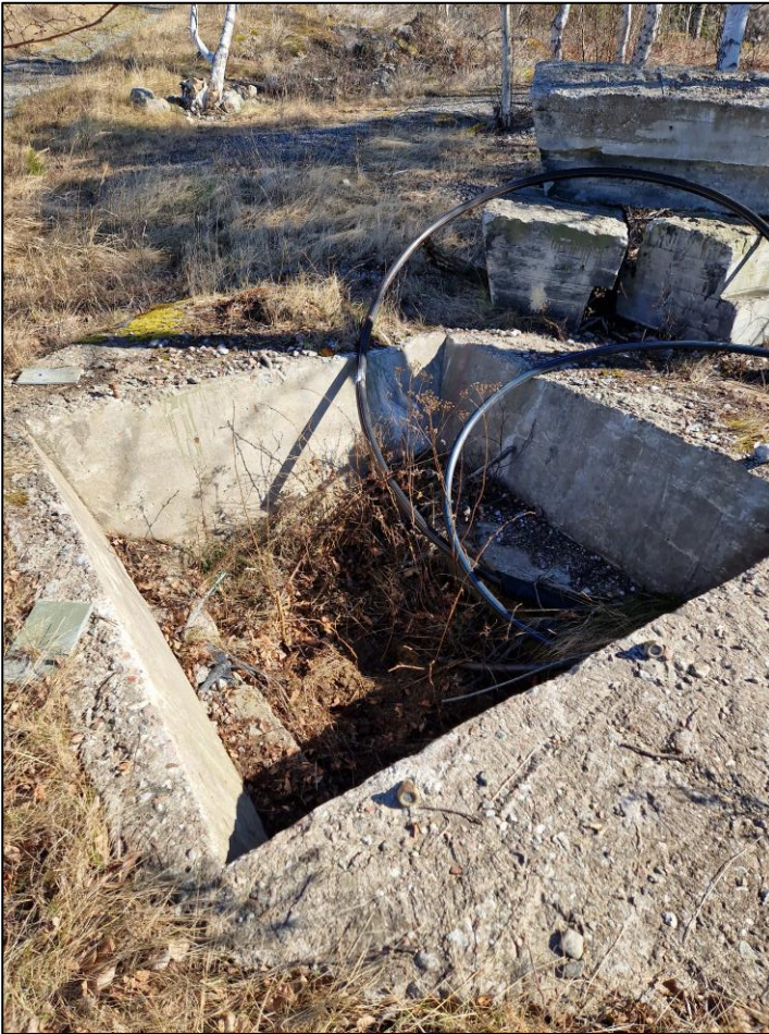
Figur 3. Området kring kabelbrunn
