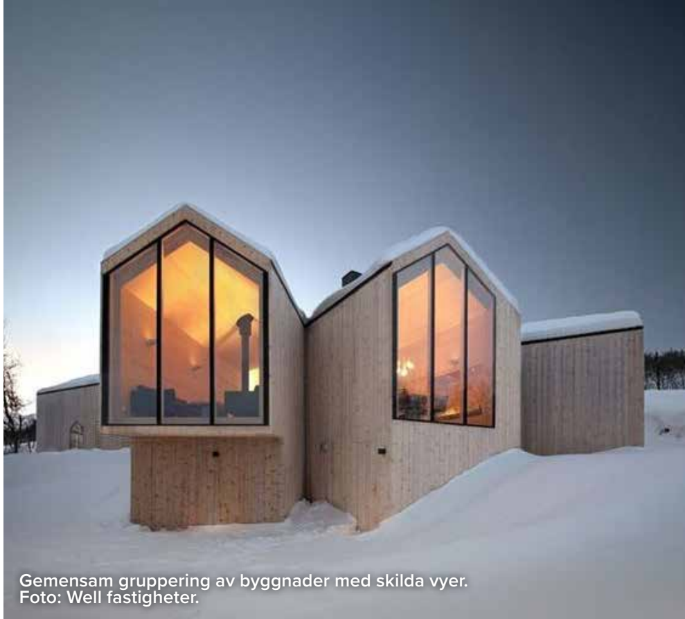
Samspel mellan byggnadsmaterial och naturen där den privata sfären hålls i direkt anslutning till byggnaden. Foto: Susanna Ringer
