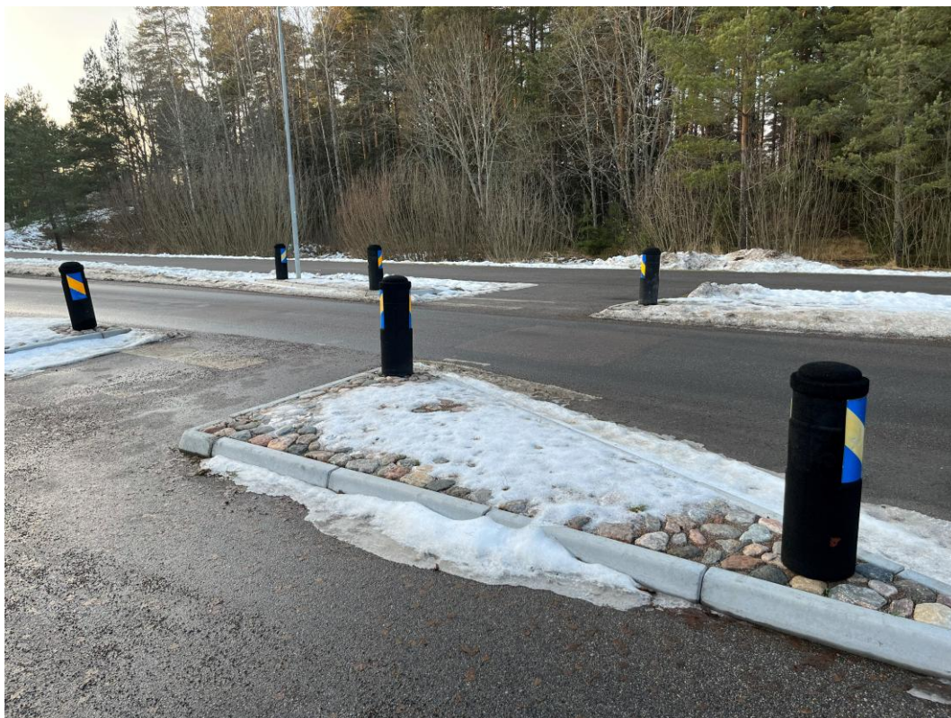
Figur 7 - Övergångsställe med avsmalning till befintlig parkering och verksamhet. Platsbesök 19/1-2026.
