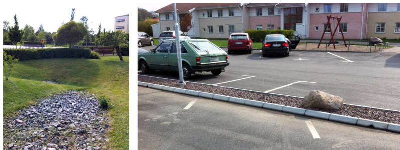
Figur 36. Exempel på makadamdike i gräsmatta och intill parkeringsyta. Källa: Stockholm Vatten och Avfall, Anläggningsbeskrivningar (2025-09-01)
