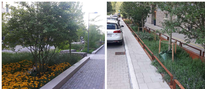
Figur 40. Exempel på nedsänkt växtbädd i gatumiljö med inlopp via kantsten (Norra Djurgårdsstaden). Källa: VA-Verket
