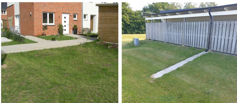
Figur 30. Exempel på infiltration i grönyta. T.v. dagvatten avleds på bred front från kvartermark till skålformad gräsyta. T.h. dagvatten avleds från utkastare till infiltration i gräsmatta.
