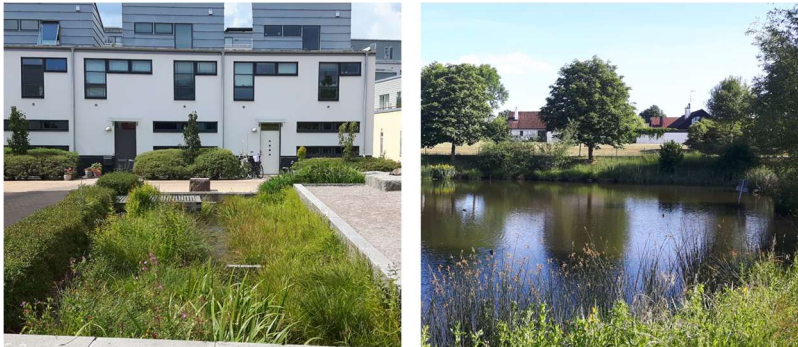
Dammar kan utformas för att passa i många olika miljöer (Bo01 Malmö t.v. och dagvattendamm Bara t.h.). Källa: VA-Verket
