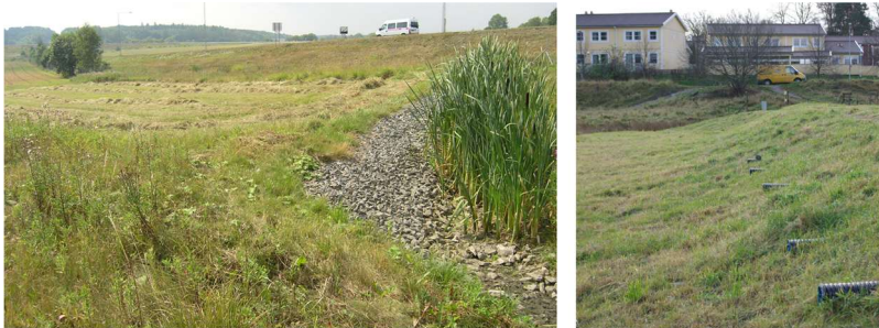
Figur 34. Exempel på översilningsyta intill väg med bred avledning. Källa: Stockholm Vatten och Avfall, Anläggningsbeskrivningar (2025-09-01)
