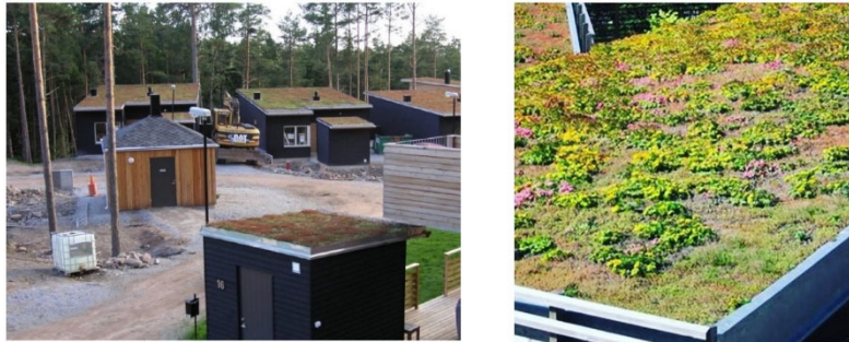
Bild 32, 33. Komplementbyggnader föreslås i planförslaget utföras med gröna sedum-tak. Genom lagring av vatten i växtbädden, avdunstning och växternas egna vattenförbrukning minskar avrinningen från taket väsentligt jämfört med ett konventionellt tak. Källa: WRS AB
