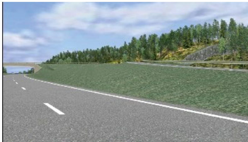
Bild 6. Bergskärningen från E22 ur bilistens perspektiv. Källa: ÅF Infrastructure AB
