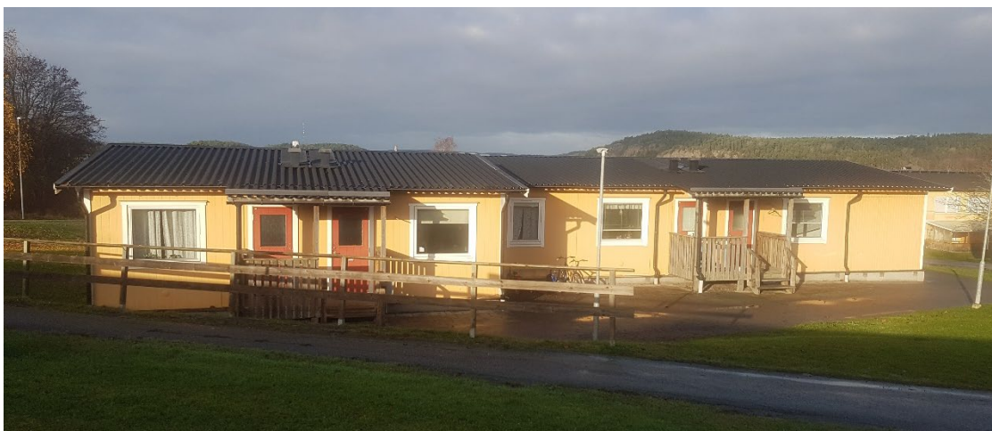
Figur 31. Byggnad som kommer att rivas.
