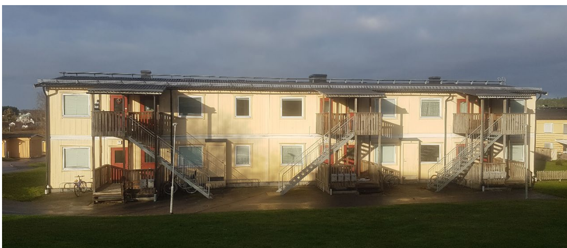
Figur 32. Byggnad som kommer att rivas.
